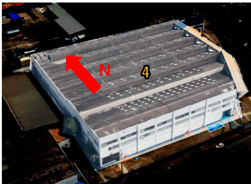
Figura 2.2: Visão da área de instalação dos painéis fotovoltaicos
